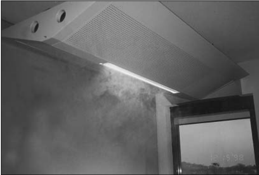
Foto 2 LUCHTTOEVOERPLENUMS
